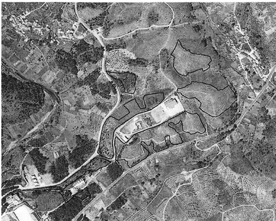
ZONA DE PILAS PEQUEÑAS
